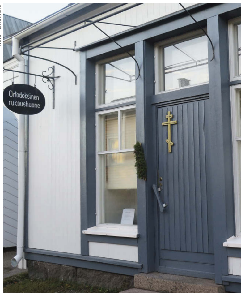
Raahen rukoushuoneen julkisivu on saanut uuden maalipinnan.
